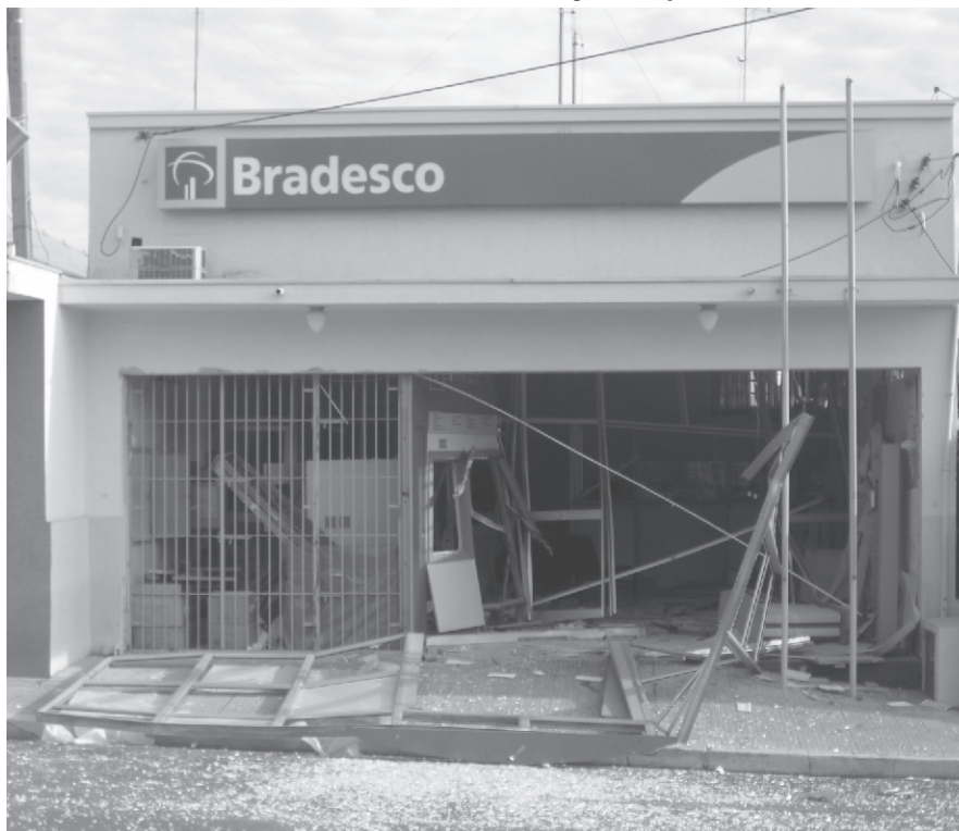
Agência ficou completamente destruída, após explosão
